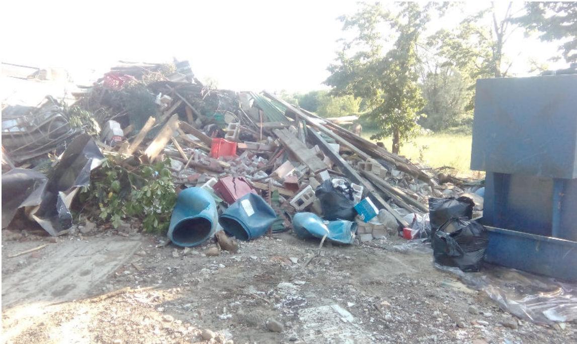
Immagine 3 - scattata mercoledì 8 giugno 2017 materiali misti + materiali demolizione edilizia
