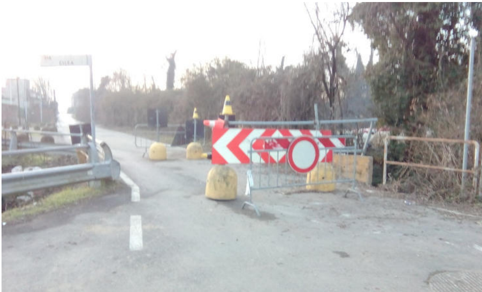
Immagine scattata domenica 26 dicembre 2016 Via Isolino - ponticello di attraversamento sopra torrente Cisnara Calibro ssde stradale ~ 3,90 metri (larghezza totale) vista da via Cilea
