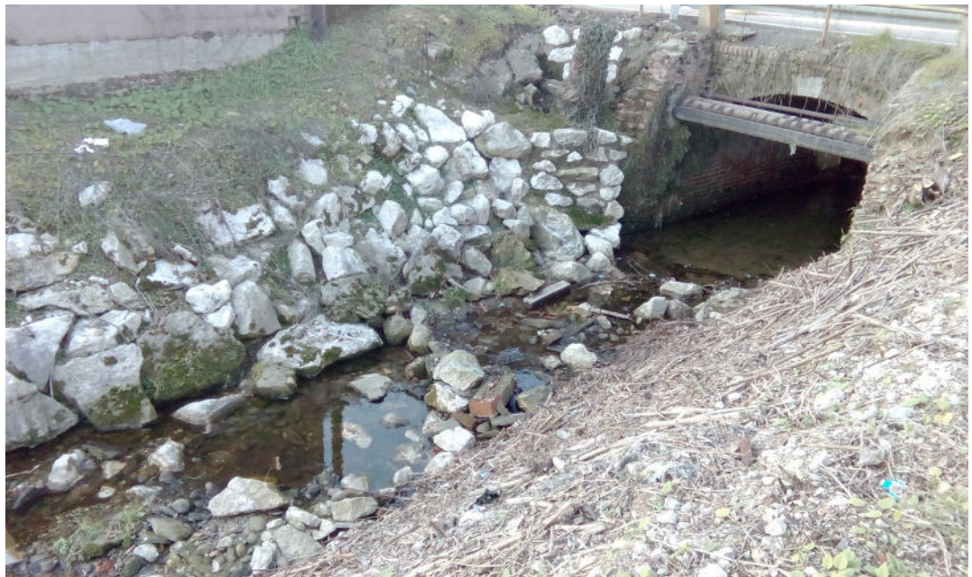
Immagine scattata martedì 3 gennaio 2017 Calibro del ponticello sul torrente Cisnara vista da via Cilea
