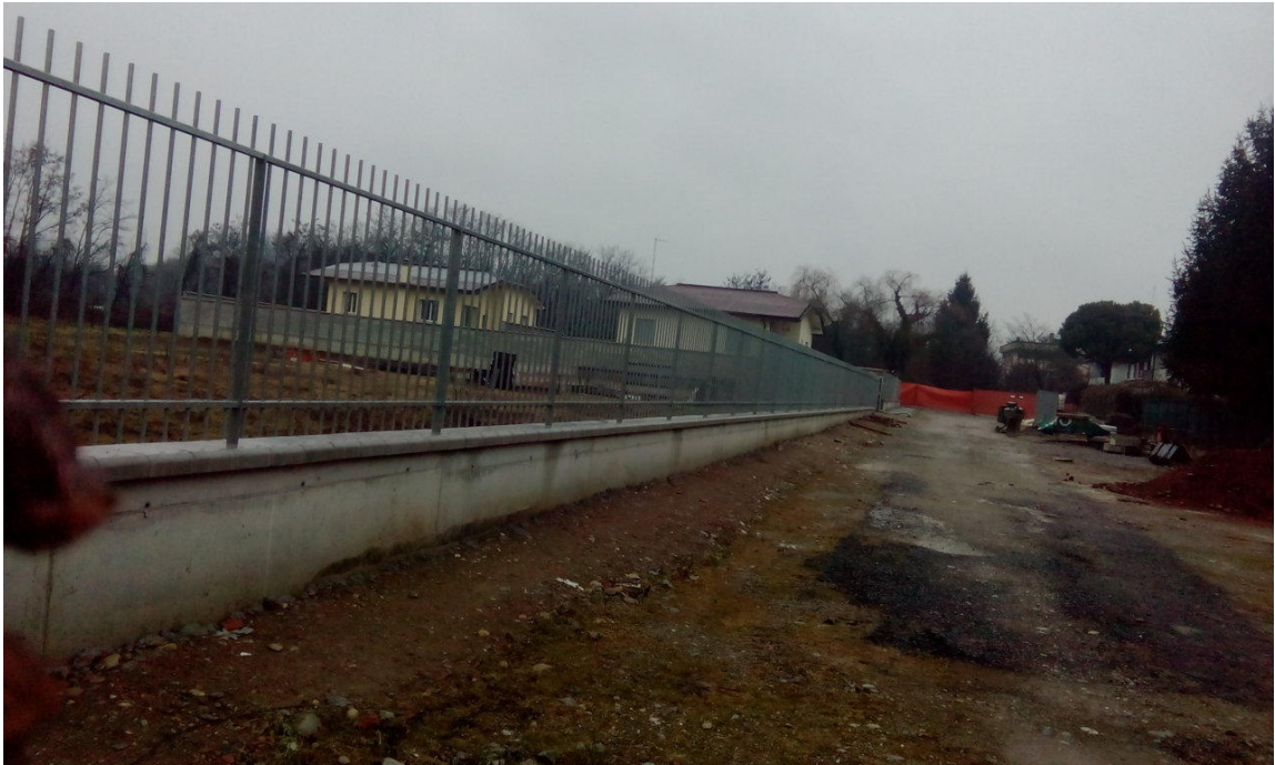
Immagine n° 1: recinzione realizzata area immobile identificato catastalmente al fg. 24, mappali 259-260-261 domenica 5 febbraio 2015
