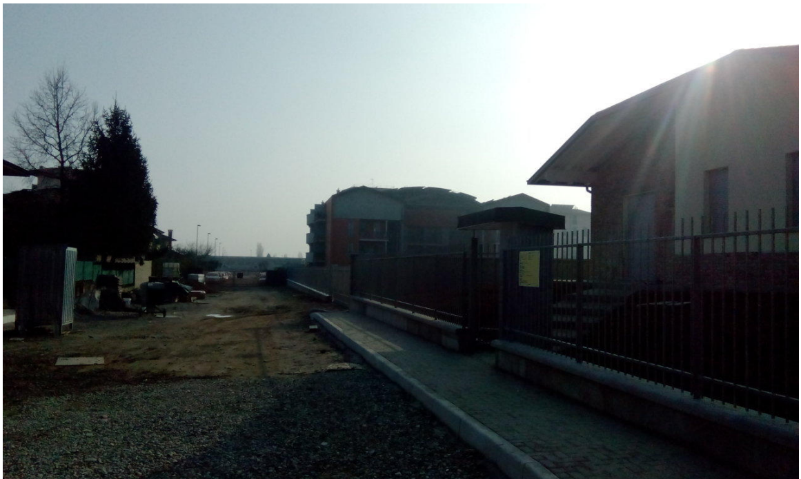
Immagine n° 3: recinzione realizzata area immobile identificato catastalmente al fg. 24, mappali 259-260-261 sabato 18 febbraio 2015
