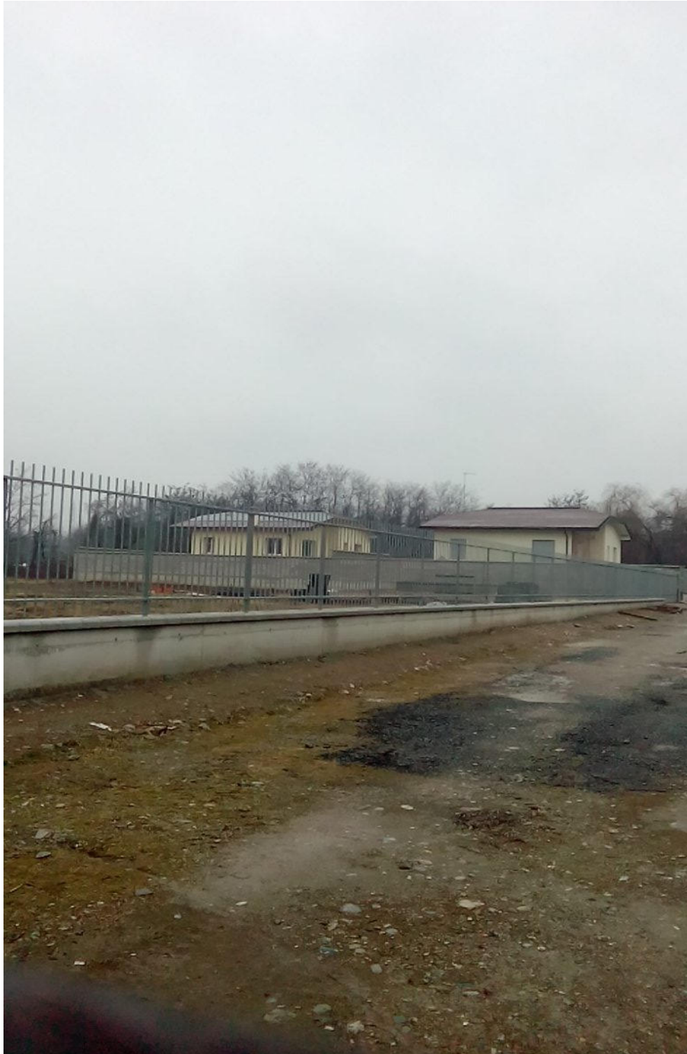
Immagine n° 2: recinzione realizzata area immobile identificato catastalmente al fg. 24, mappali 259-260-261 domenica 5 febbraio 2015
